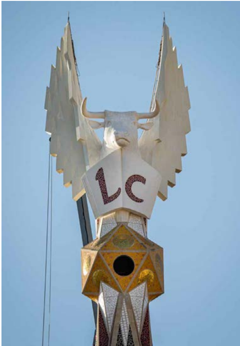
ALAS DE HORMIGÓN BLANCO EN LA TORRE DEL EVANGELISTA LLUC
