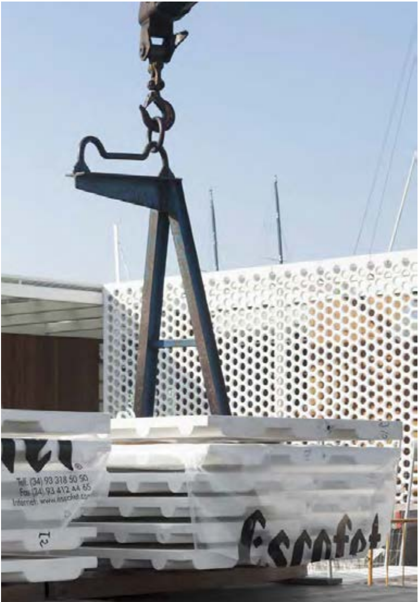
ACOPIO Y TRANSPORTE DE LAS PIEZAS
